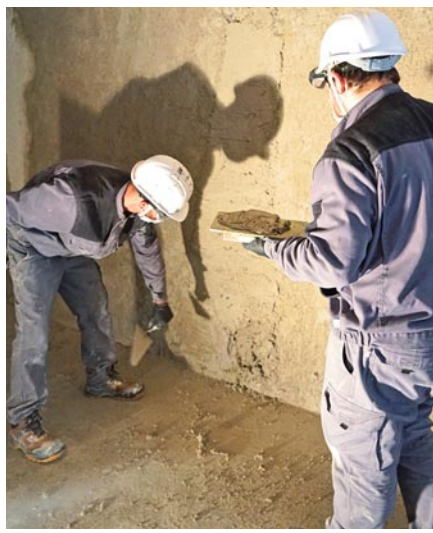
C'EST LE CHANTIER ! Lundi 18 mai , le chantier d'insertion œuvrant pour la réhabilitation du Fort de Feyzin a redémarré dans le respect des gestes barrières qui sont devenus le quotidien des salariés sur place.
